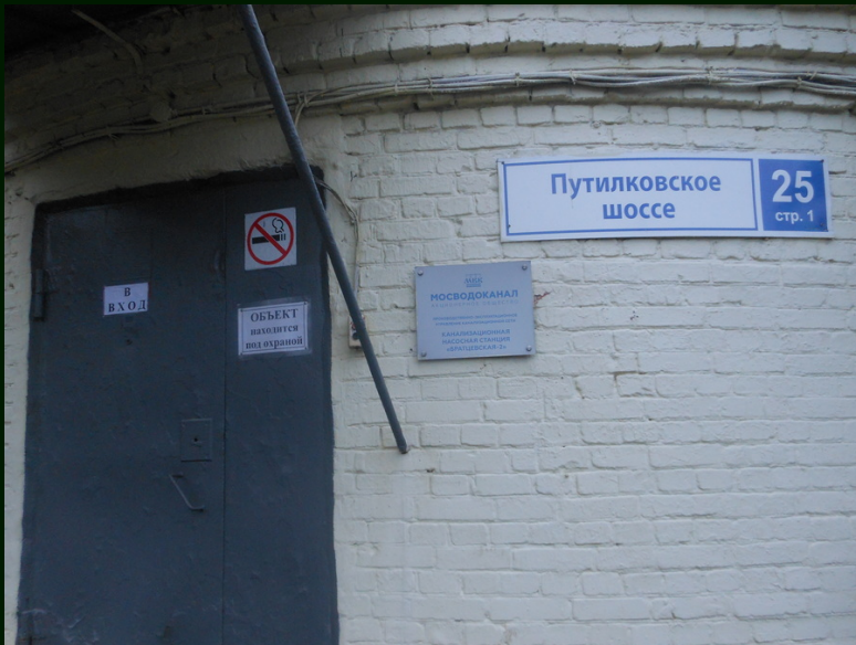
2020-09-19-9857 – Канализационная насосная станция «Братцевская-2»
