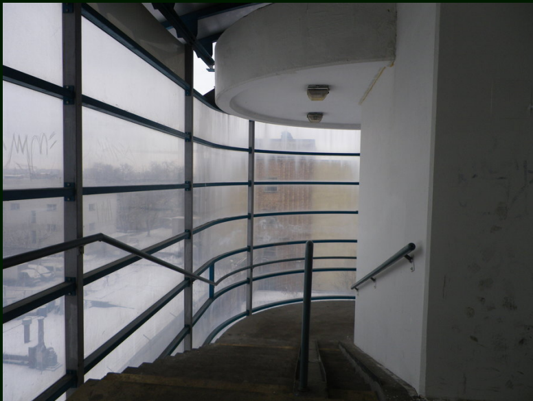
2012-01-03-5731 Внутри пешеходного моста. Это со стороны Угрешского проезда такой подъём на мост.
