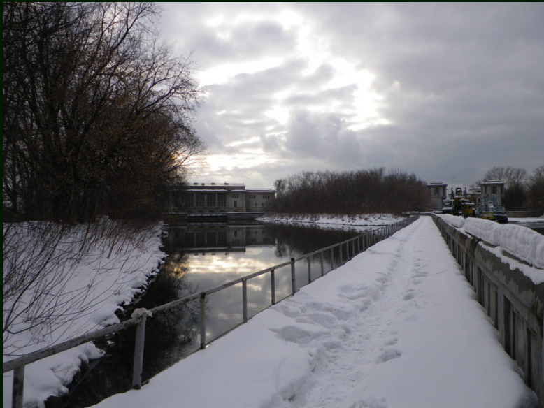
2011-03-12-2880 ГЭС и Малый Шлюз
